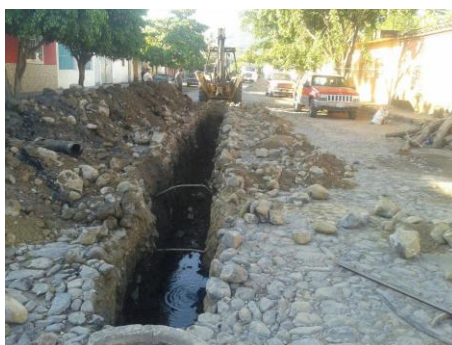
REHABILITACIÓN DE LÍNEA SANITARIA EN LA CALLE 16 DE SEPTIEMBRE CON TUBERIA DE 8" EN LA RESOLANA, MUNICIPIO DE CASIMIRO CASTILLO
