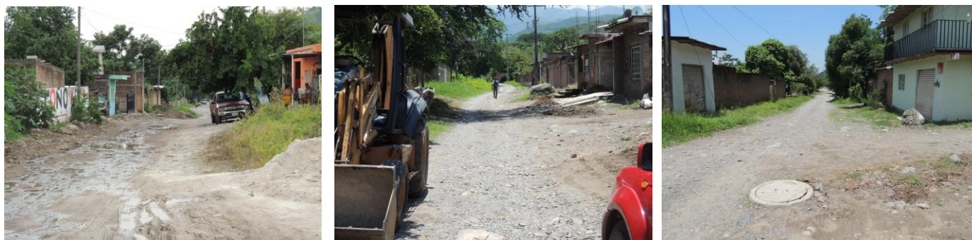
CONSTRUCCIÓN DE EMPEDRADO EN LA CALLE LUIS CABRERA" en la Naranjera
