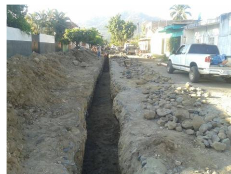
REHABILITACIÓN DE LÍNEA SANITARIA EN LA CALLE 16 DE SEPTIEMBRE CON TUBERIA DE 8" EN LA RESOLANA, MUNICIPIO DE CASIMIRO CASTILLO
