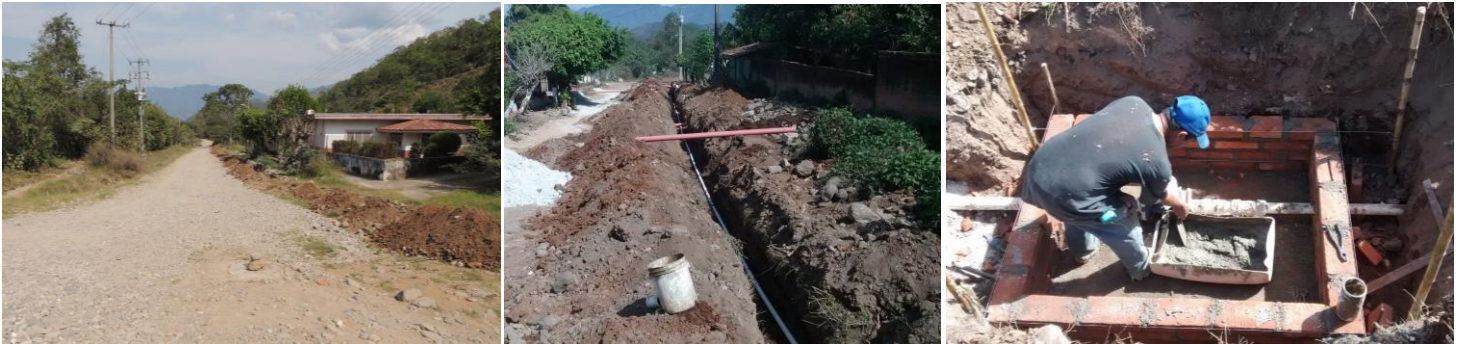
CONSTRUCCIÓN DE RED HIDRAÚLICA EN LA CALLE FRANCISCO I. MADERO EN LA LOCALIDAD DE PIEDRA PESADA, MUNICIPIO DE CASIMIRO CASTILLO
