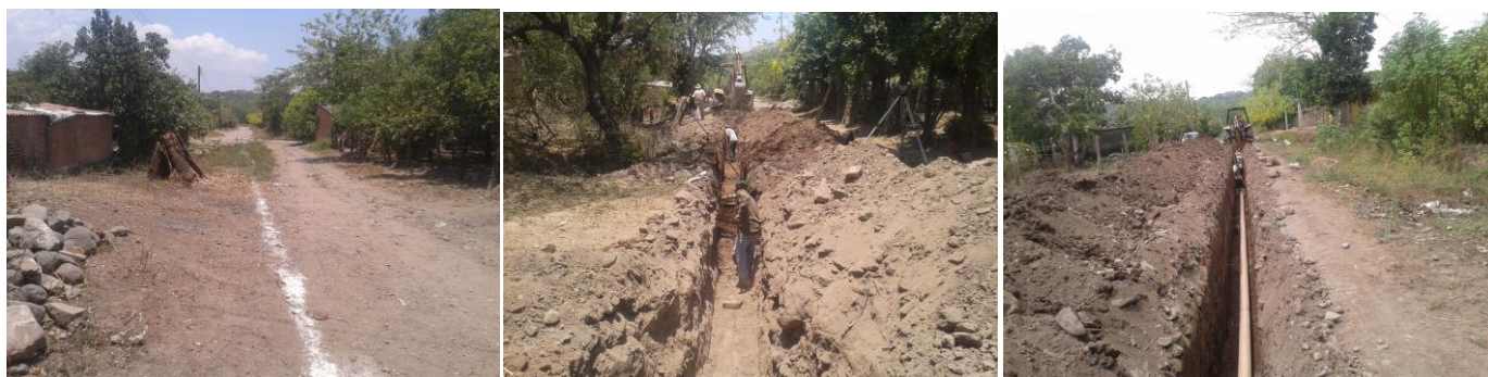
CONSTRUCCIÓN DE RED SANITARIA EN VARIAS CALLES DEL CORRAL DE PIEDRA, MUNICIPIO DE CASIMIRO CASTILLO
