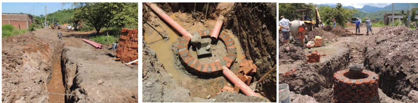
CONSTRUCCIÓN DE RED SANITARIA EN FRACCIONAMIENTO "EL ZAPOTILLO"
