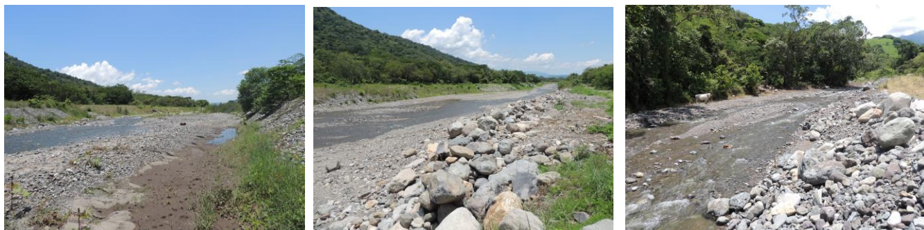
DESASOLVE DE VARIOS ARROYOS Y RIOS DEL MUNICIPIO DE CASIMIRO CASTILLO
