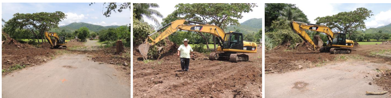
CONSTRUCCIÓN DE PUENTE DE ACCESO A LA LOCALIDAD DE BENITO JUÁREZ
